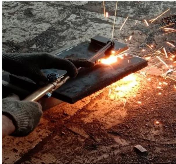
Gambar 4.8 Proses pemotongan Material
