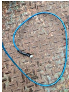
Gambar 13. Kabel yang telah diperpanjang
