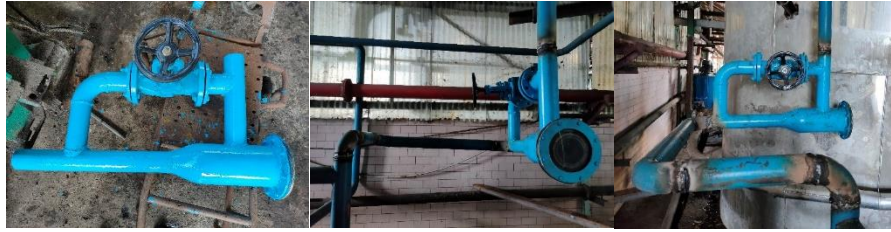
Gambar 13. Pemasangan Resin Trap
