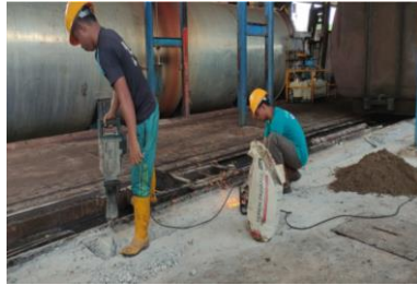
Gambar 3.4 Pembuatan jalur pipa hidrolik indexer
