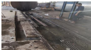
Gambar 3. 6 Pemindahan Pipa Hidrolik ke Jalur Pipa
