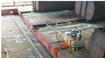
Gambar 3.5 Pembuatan jalur pipa hidrolik indexer
