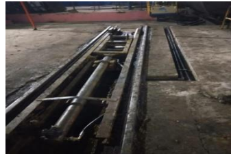
Gambar 4.1 Setelah dilakukan reposisi pipa hidrolik indexer
