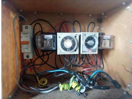
Gambar 1.4 Sistem Kontrol Alat Yang Terpasang di Leidong West Mill
