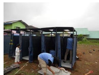
Gambar 3. 3 Toilet darurat di pengungsian (Dokumen Pribadi, 2021)
