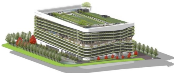
Gambar 2.7 Bentuk Akhir Bangunan
