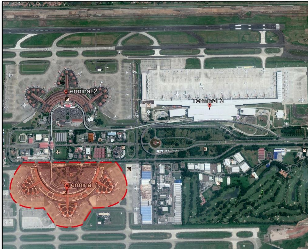
Gambar 1.2 Lokasi Penelitian Terminal 1 Bandara Soekarno-Hatta
