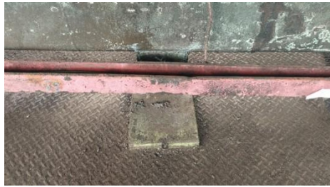
Gambar 20. Boardesk Setelah Dipasang Interlock
