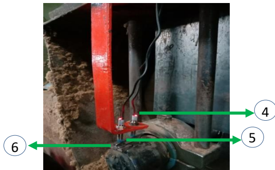
Gambar 6 Pemasangan Sensor pada fiber/shell conveyor
