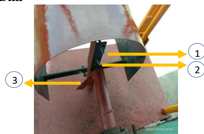
Gambar 5 Pemasangan sensor pada fueldistributing conveyor
