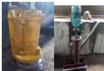
Gambar 6. Submersible Pump (kiri), Toto Pump (kanan)
