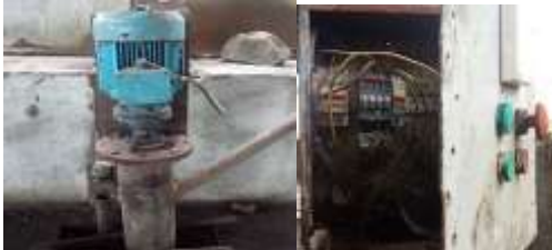
Gambar 18. Instalasi di Transfer Carriage Pit
