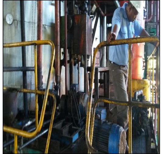
Pembongkaran pompa vakum
