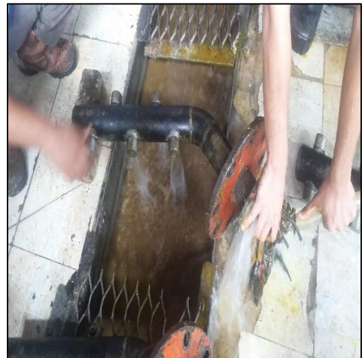
Pengecekan kondisi nozzle
