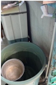
Gambar 3. Kondisi Sumber Air dari Sumur jet pump
