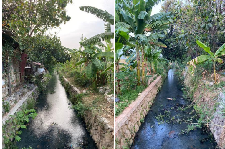
Gambar 1.1. Selokan Air di Luar Perumahan. (Sumber: Dokumentasi Pribadi, 2024).
